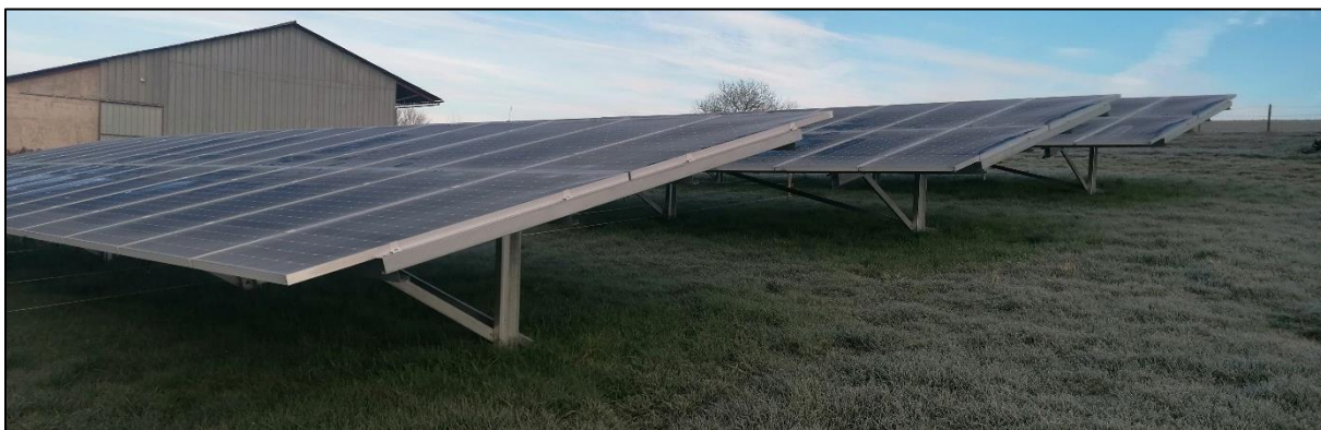
Projet expérimental réalisé par Valeco. Aucune différence entre l'extérieur des panneaux et l'intérieur
