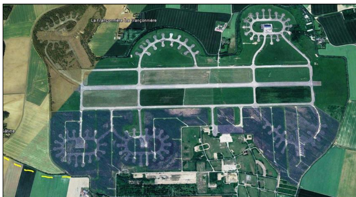
Projet photovoltaïque de 130 hectares de 60MWc réalisé par EDF sur l'ancienne base de Crucey (reconversion de friche militaire).
