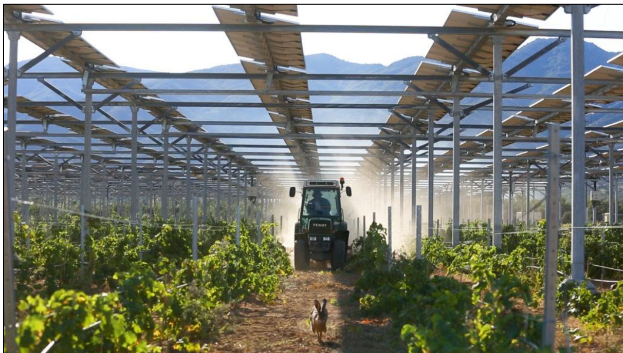
Exemple n°1 d'installation Agrivoltaïque au-dessus de vigne
